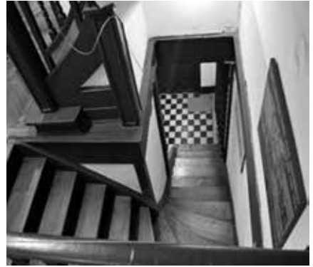
Escalera al segundo piso
