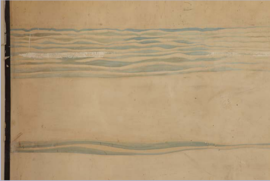
Limpieza heterogénea, manchas de diverso origen y faltantes de pintura. Fotografía: Hotel Gran Palace, por José Luis Rissetti.
