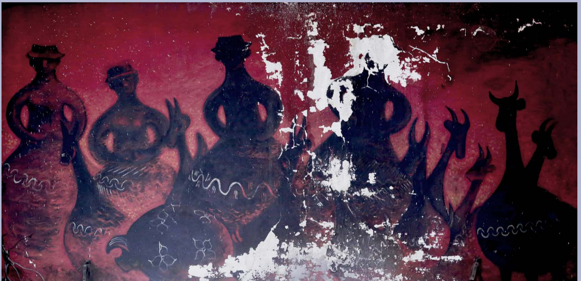
A pesar de que el mural fue declarado monumento histórico en el 2011, como se aprecia en la imagen ha sufrido severos daños por efectos de la humedad. Así luce en la actualidad (2018) y aún no han existido avances para su restauración. El mismo artista ofreció arreglarlo en vida, pero su propuesta no tuvo acogida. Fotografía: Mario Ruiz Ortiz.
