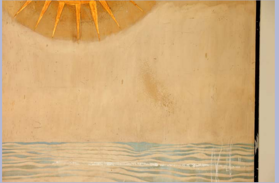
Limpieza inadecuada, manchas de líquido graso, incisiones en la superficie. Fotografía: Hotel Gran Palace, por José Luis Rissetti
