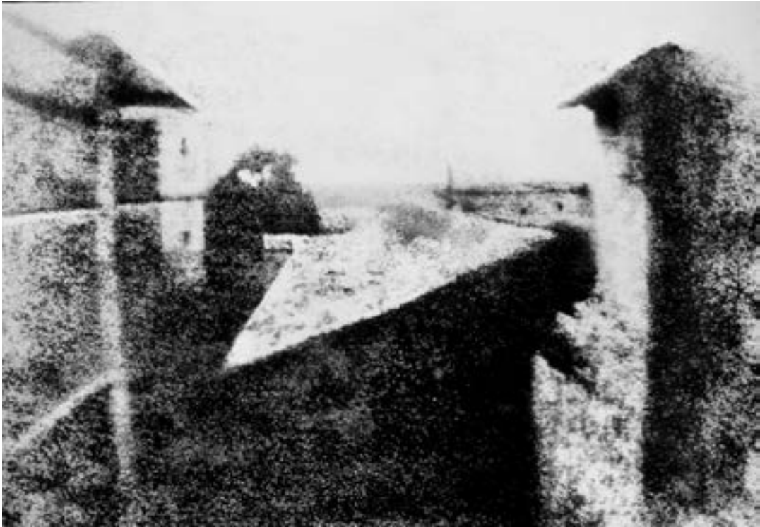
Vista de Le Gras desde una ventana. Nicéphore Niépce, 1826(27). Primera fotografía permanente tomada con éxito por precisión de ocho horas de exposición por esto los edificios están iluminados tanto por la derecha como por la izquierda.
