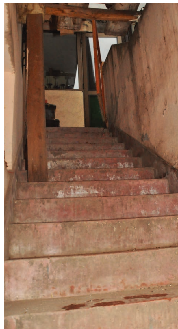
Escalera del Subterráneo. Ítalo Retamal.
