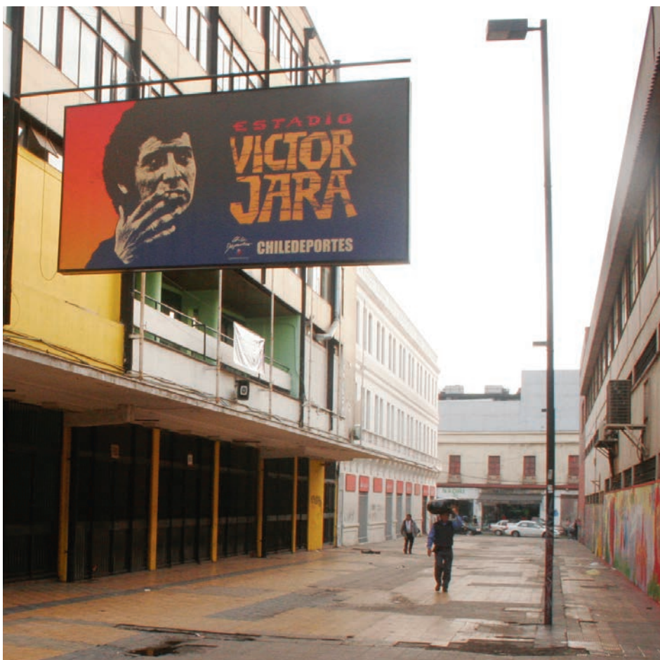
Fachada Estadio Víctor Jara, 2009. Fundación Víctor Jara. Archivo Consejo de Monumentos Nacionales.
