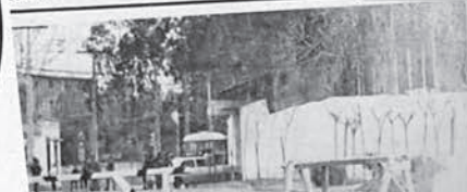
RAFIA se aprecian algunas ventanas rotas. El portón principal. Adentro cayeron algunos muros y se saltaron las puertas de la casa.
